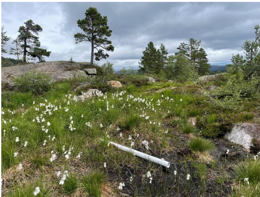
Figur 4-25. Smårør som drenerer en forsenkning på en liten tursti gjennom prosjektområde Berge (foto: H. Liebel/Asplan Viak).
