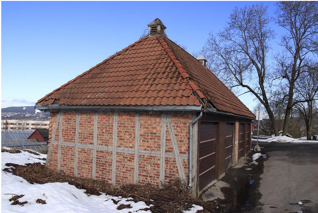
Fasade Garasjen mot sør
