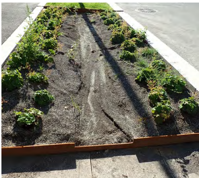
I dette anlegget er mye av vekstmediet vasket ut allerede før plantene har etablert seg. Erosjonsproblematikken kunne vært adressert med en stripe elvegrus i midten, bruk av ferdige staudematter eller ved å lede overvann utenom regnbedet i første vekstsesong.
