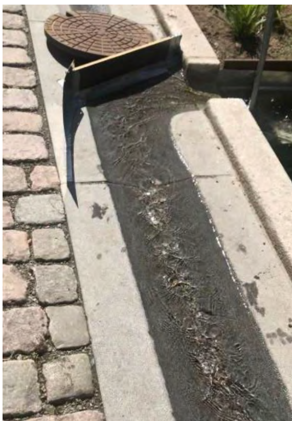
Testing av regnbedene i Deichmans gate viste at terskelementet ved innløpet ikke var dypt nok til å lede tiltenkte overvannsmengder til bedet. Testingen avdekket også at jordoverflaten i et av regnbedene var anlagt skjevt slik at vannet gikk i overløp over kanten lenge før det prosjekterte fordrøyningsvolumet var fylt opp. Foto: Nevedda Sivakumar og Gerd Minde.
