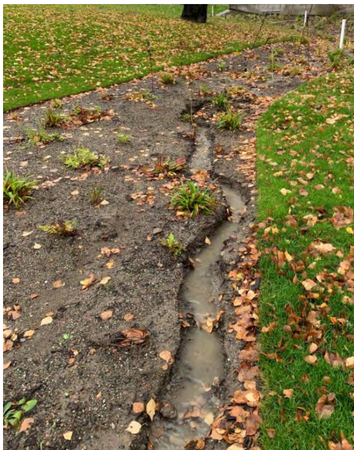
I dette anlegget håndteres overvannet i en kombinasjon av regnbed og vadi. Den skrå overflaten gjør tiltaket ekstra utsatt for erosjon. Problematikken forsterkes av at overvannet stammer fra taknedløp som gir vannet høy hastighet inn i vadien.
